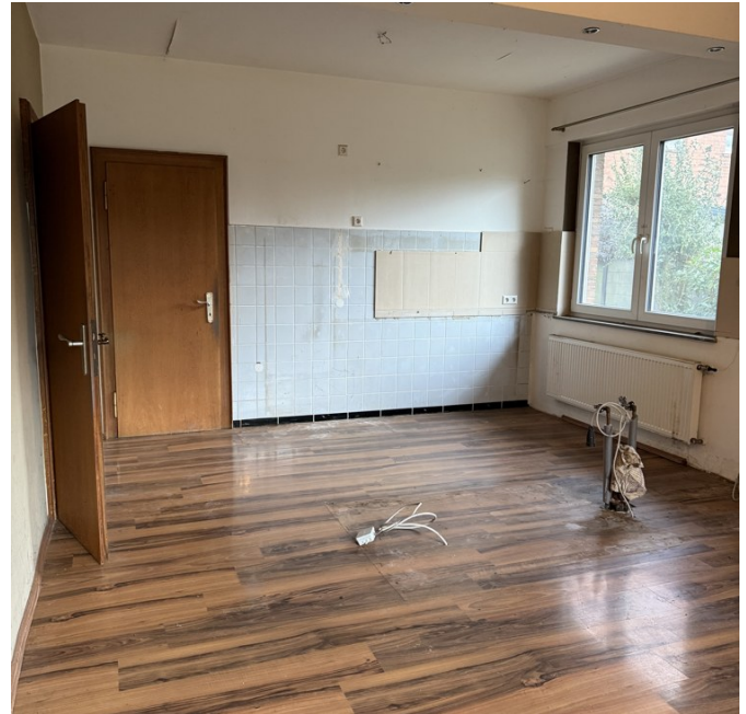
Fensterseite des Küchenraums
