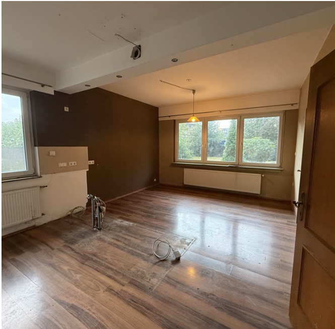
Aktueller Zustand ohne Einbauten
