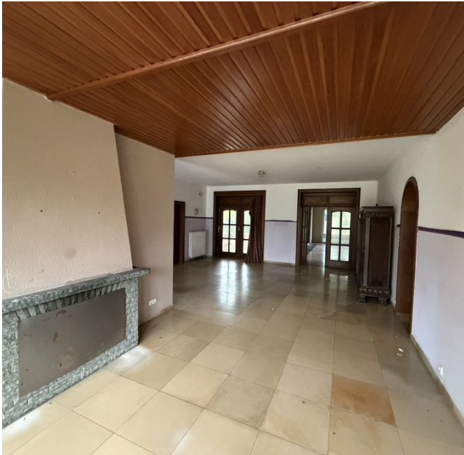
Kaminbereich und Holzdecke
